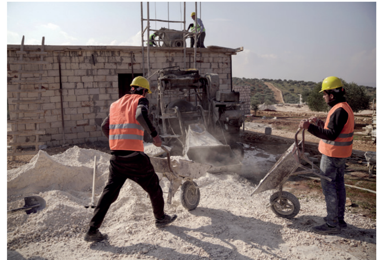
Erste Baumaßnahmen werden im Auftrag von Islamic Relief Deutschland umgesetzt
